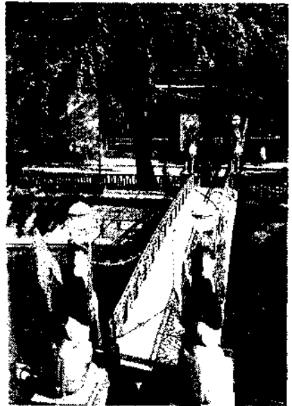
Рис. 8.5. Пішохідний міст в Санкт-Петербурзі.
