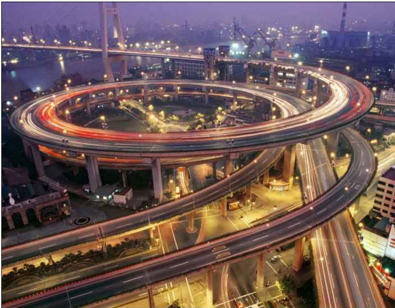
Мост Нанпу (естакада в вигляді спіралі) Китай, Шанхай
